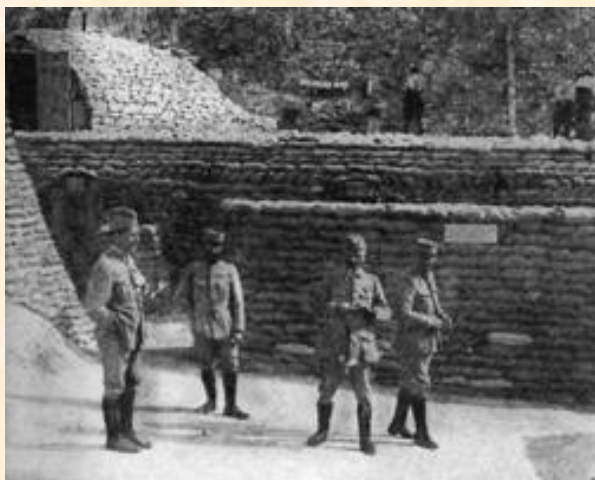
Французские оборонные сооружения, Сомма, 1916 г.
